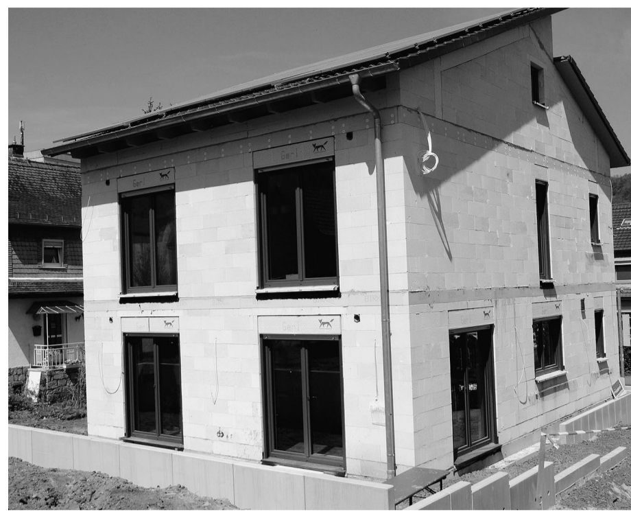
Optimiert werden die Speicherwerte des Effizienzhaus Plus durch eine massive Gebäudehülle aus Hebel Porenbeton. Durch eine homogene Materialstruktur und ein durchdachtes, aufeinander abgestimmtes System lässt sich damit eine optimal abgedichtete, wärmebrückenfreie Gebäudehülle erstellen. FOTO: RITA JACOBS
